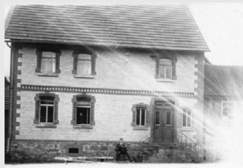
Firmengebäude im Gründungsjahr
