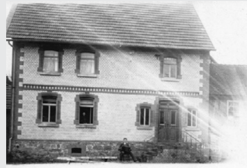
Firmengebäude im Gründungsjahr
